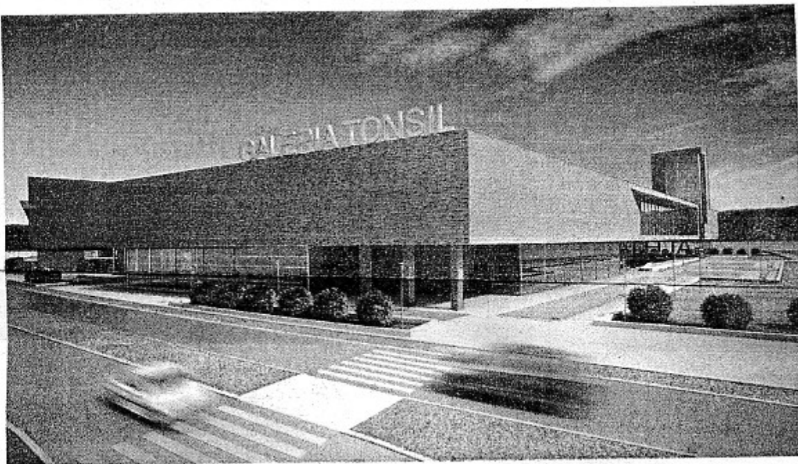
▲ A miało być tak pięknie... Zanoszą się na to, że puste hale Tonsilu będą straszyły jeszcze wiele lat...
